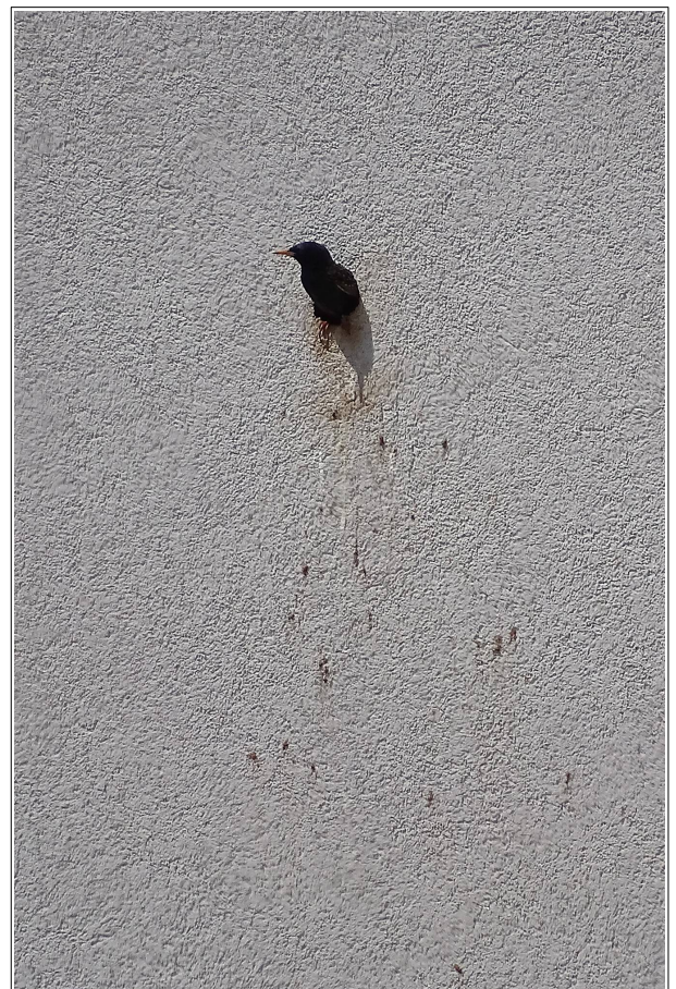
Bild 3: Spechtlöcher in der WVDS-Dämmung der Fassade des Werksgebäudes (rot umrandet)
