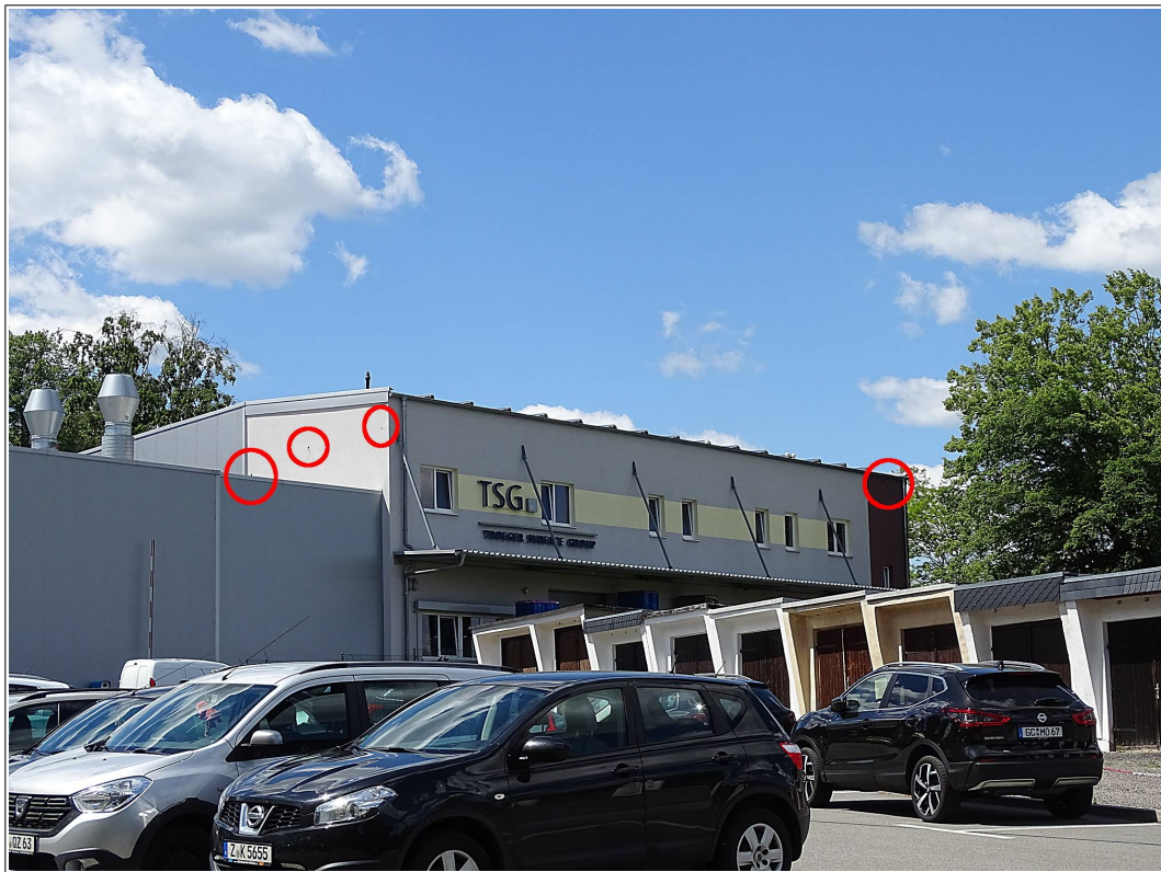
Bild 3: Spechtlöcher in der WVDS-Dämmung der Fassade des Werksgebäudes (rot umrandet)
